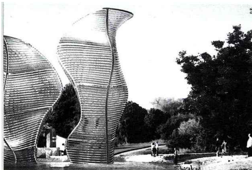
▲ Photobioreacteur projet aux États Unis d'une sculpture monumentale en aluminium et verre comportant sur de multiples niveaux des bacs où des algues se développent en étant exposées au soleil. Les algues seraient ensuite récupérées et compostées pour produire du biogaz
